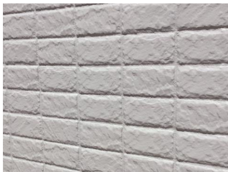
目地部分施工の良い例
