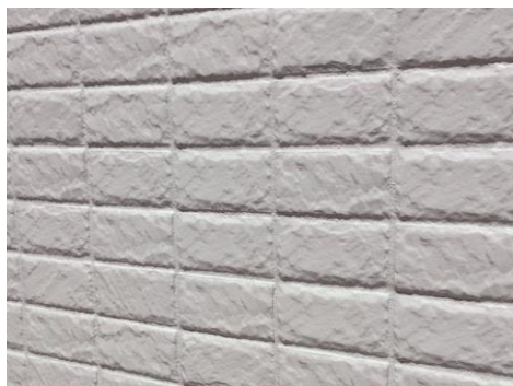
目地部分施工の良い例
